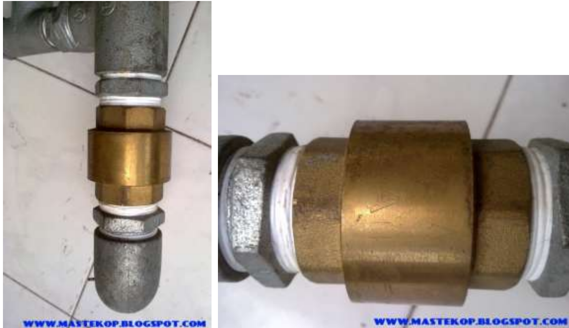
Gb-07. Posisi klep tekan, perhatikan posisi arah panah.
