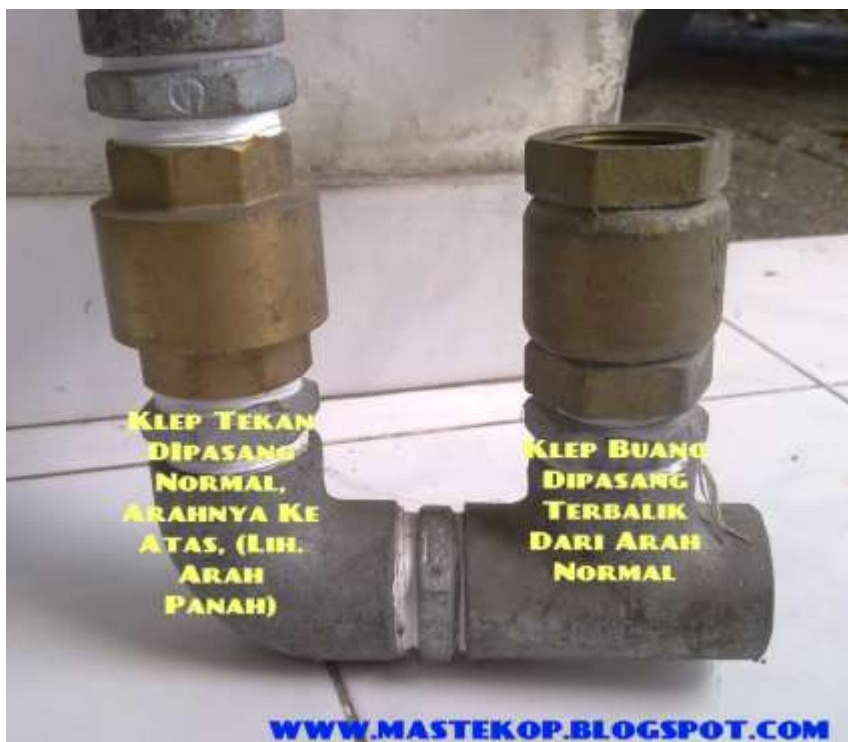
Gb-08. Pemasangan klep buang dan klep tekan, berlawanan arah.
