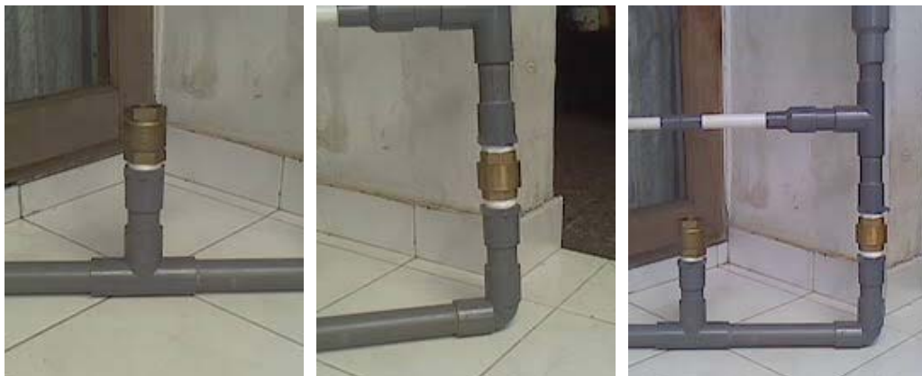
Gb – 02. Sambungan Pipa dan Klep
