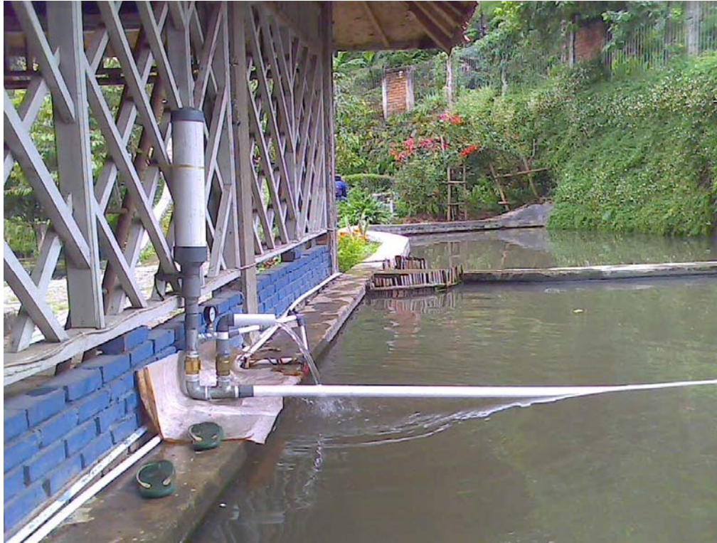
Gb – 11. Konstruksi pemasangan Pompa.
