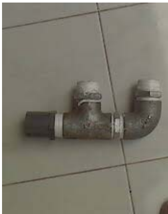
Gb – 06. Sambungan Badan Pompa menggunakan Besi lebih kompak
