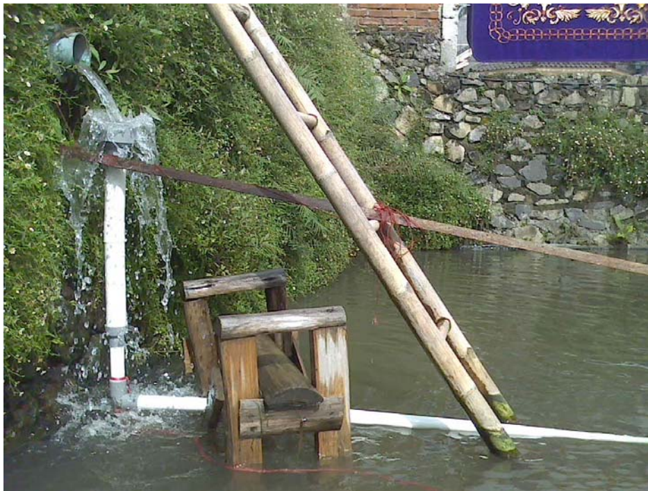
Gb - 13. Konstruksi Penyambungan Pipa Penghantar dengan Sumber Air.
