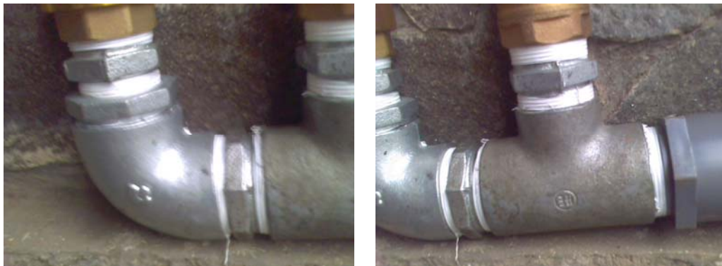
Gb - 21. Konstruksi sambungan L dan T pompa 1 ½ inchi.
