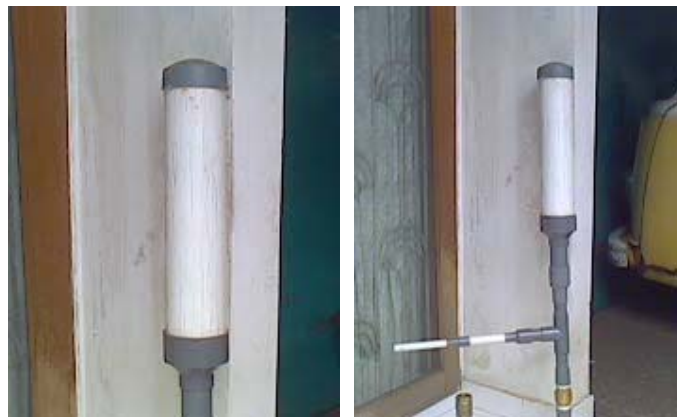
Gb – 03. Tabung Udara Pompa Hidram
